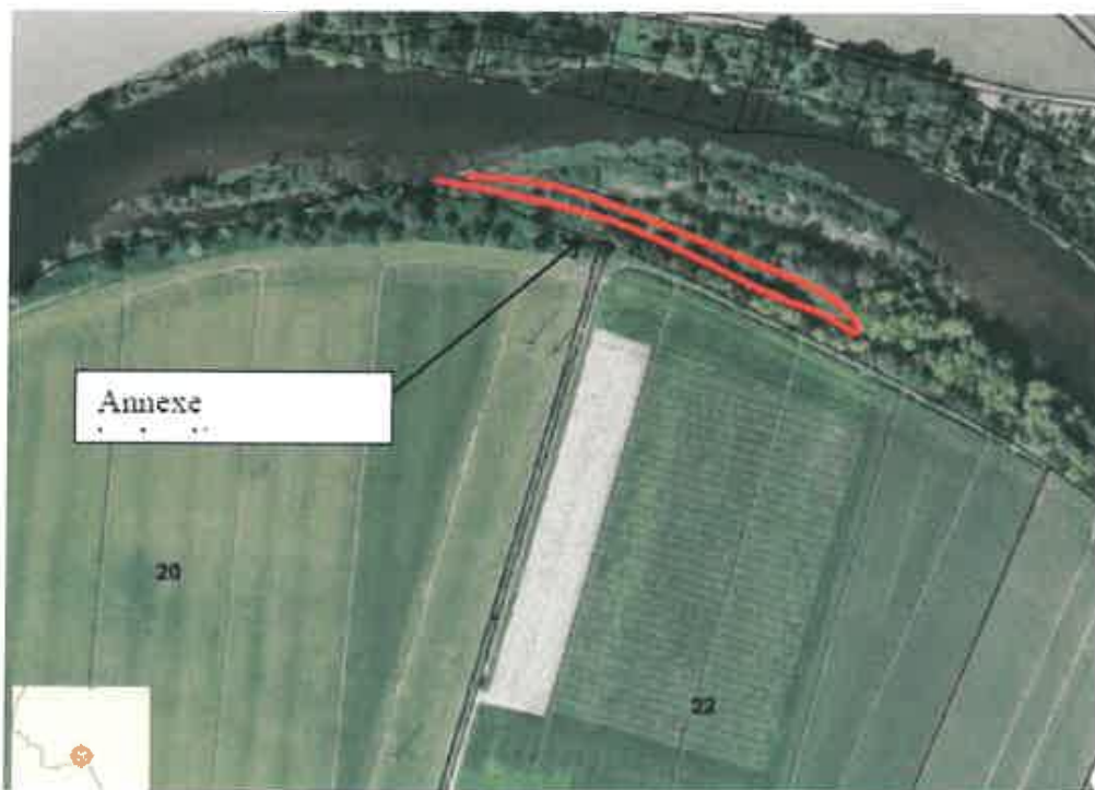
L'annexe hydraulique au lieu dit de « la Caline »
